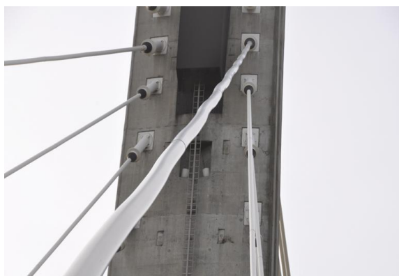
Fot. 13. Deformacja rury osłonowej liny
