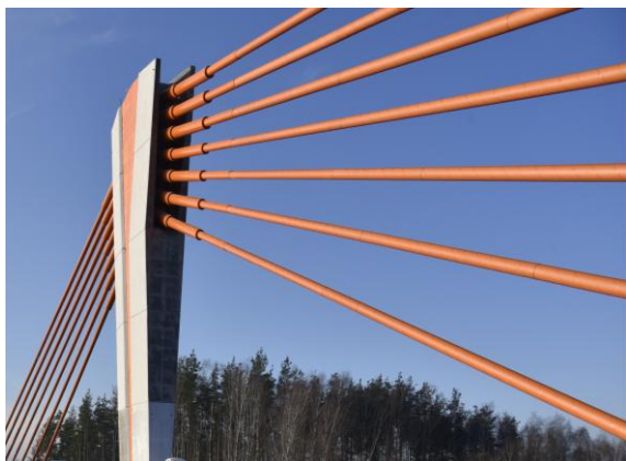
Fot. 8. Ciężna podwieszające bez uszkodzeń
