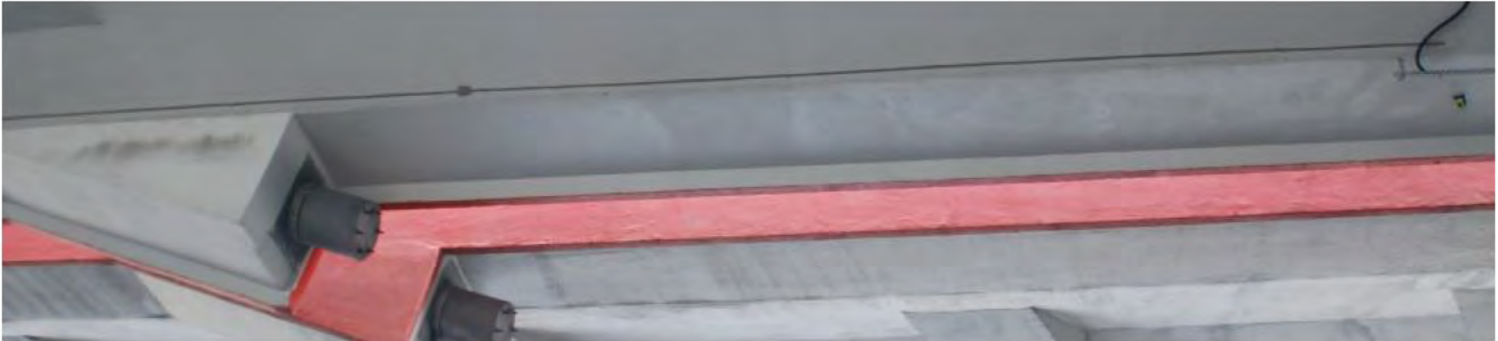
Rys. 18 Bruzda po instalacji czujnika światłowodowego
